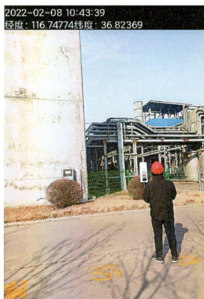
2#燃气轮机组排气筒 (DA002)
