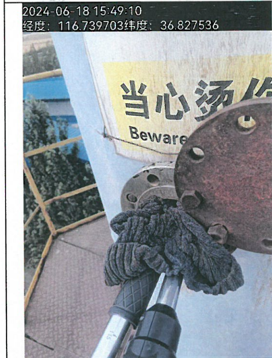
附图 3: 对甲酚碱熔 (DA041) 处理设施后 废气采样
