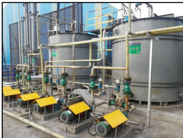
贫液储槽、富液储槽
