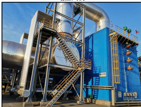
SCR 脱硝装置
