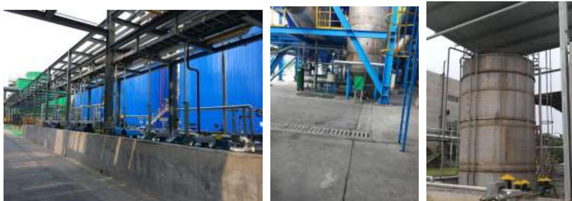
图4-4 罐区围堰及装置区地沟
