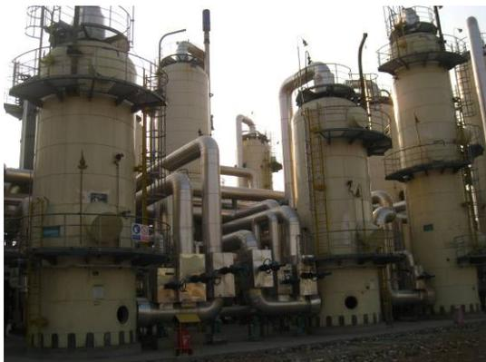
焦炉气压缩装置
