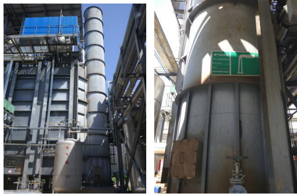
图 3-4 废气排放口采样平台和标识牌
