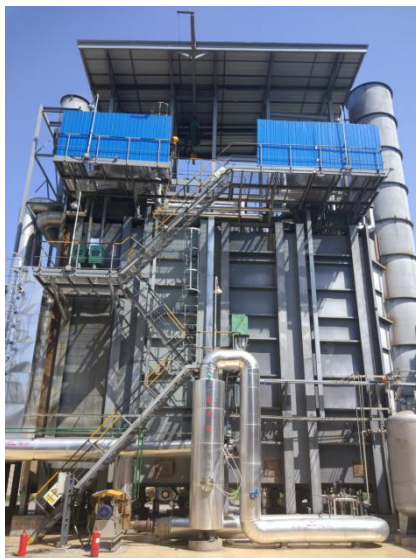
图 3-1 废气处理设施和排气筒
