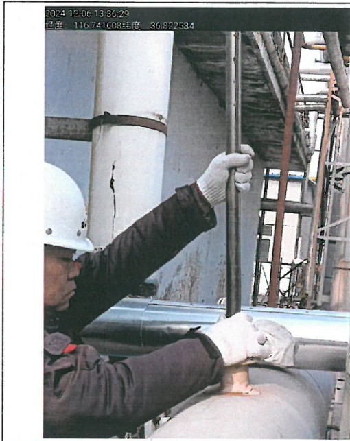
附图 1: (DA057) 三期酚氰废水处理站 1#处理设施前废气采样
