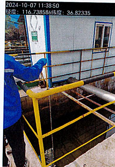
三期酚氰废水处理站清水池
