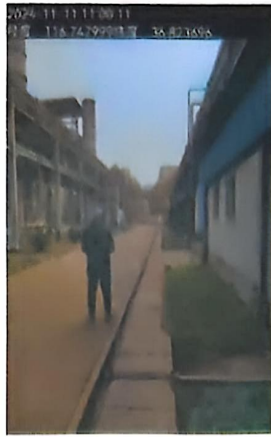
3#燃气轮机组排气筒 (DA018)
