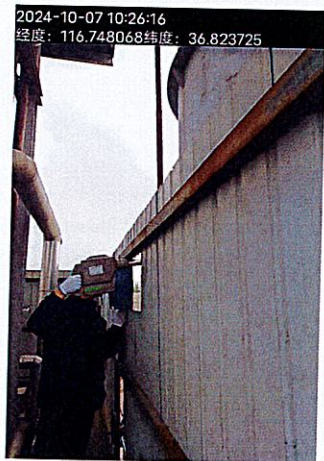
3#燃气轮机组排气筒 (DA018)
